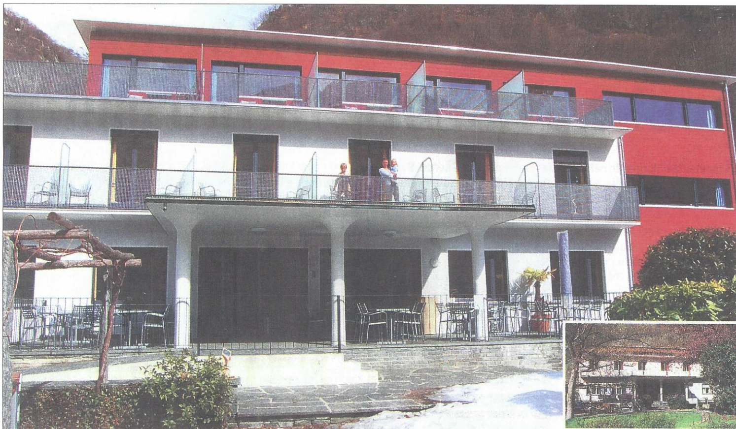
Il «Cristallina» è stato costruito negli anni 1955 - 1956 (foto piccola a destra). Dopo che Marco Kälin acquistava la casa nel 1998, questa dopo più di quarant'anni di esercizio aveva bisogno di essere risanata. Fino al termine della ristrutturazione, l'albergo è stato gestito nel vecchio stile.
