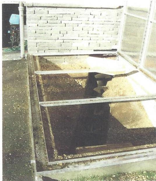
Foto 4: vasca esterna utilizzata per il riempimento del silo
